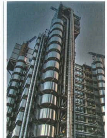
Bild 1: Die Technik im Vordergrund, wie bei der Lloyds-Versicherung in London, ...
