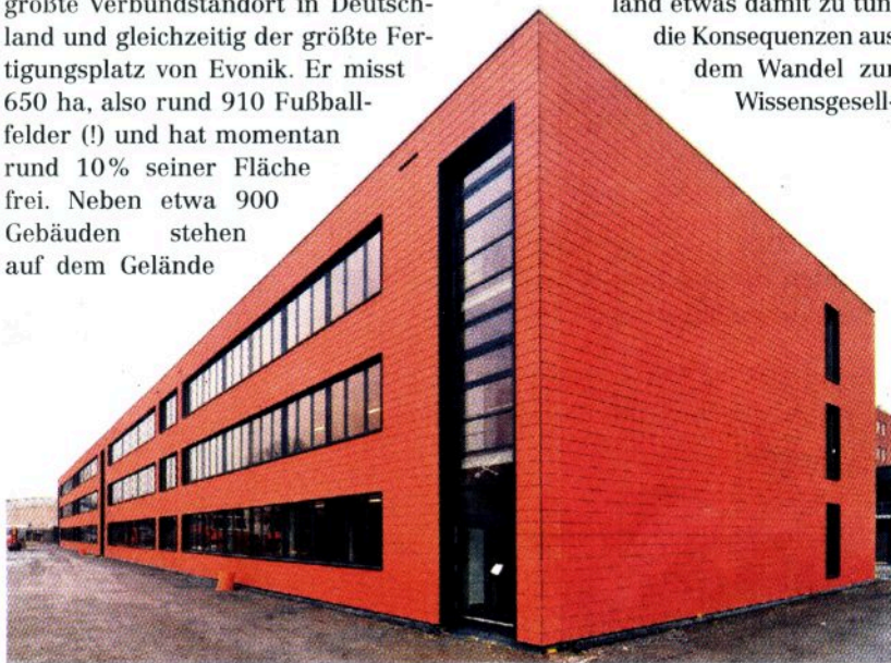
Rund 20 Mio. € wurden in den Neubau des Labor- und Technikumsgebäudes investiert.
